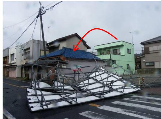
図1 強風により飛散した太陽電池アレイ
